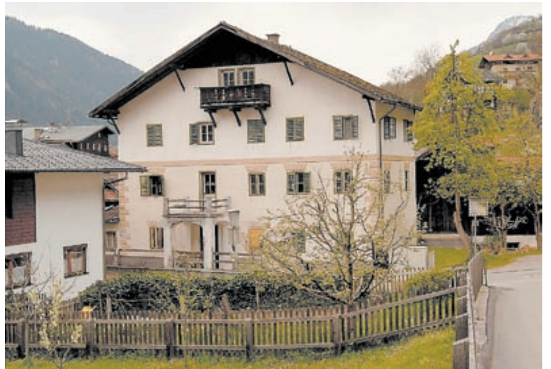
Das Coelli-Haus in Oetz ist derzeit baufällig. Im Jänner fahren Baumaschinen auf. Foto: Stecher
